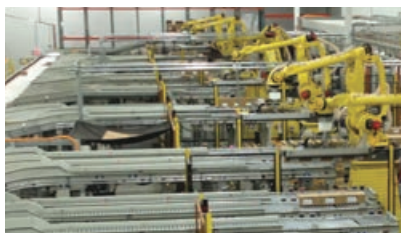
Transporte en pallets y despaletización
